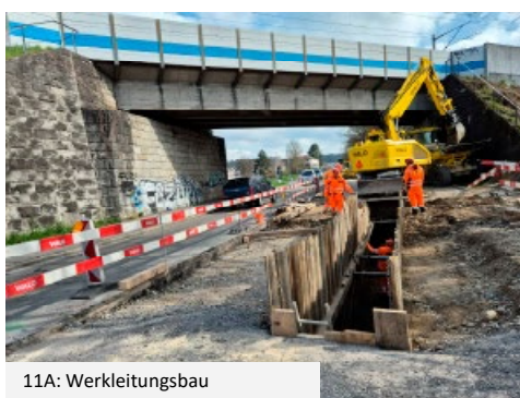
11A: Werkleitungsbau
