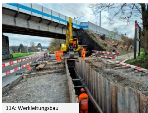
11A: Werkleitungsbau
